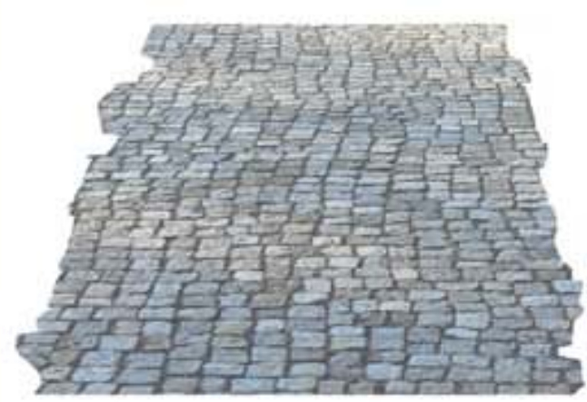
Belag aus Granitklein Stein, Passé Oberfläche gebrochen, zur Verbesserung der Barrierefreiheit Teilbereiche (Wege) mit gesägter Oberfläche
